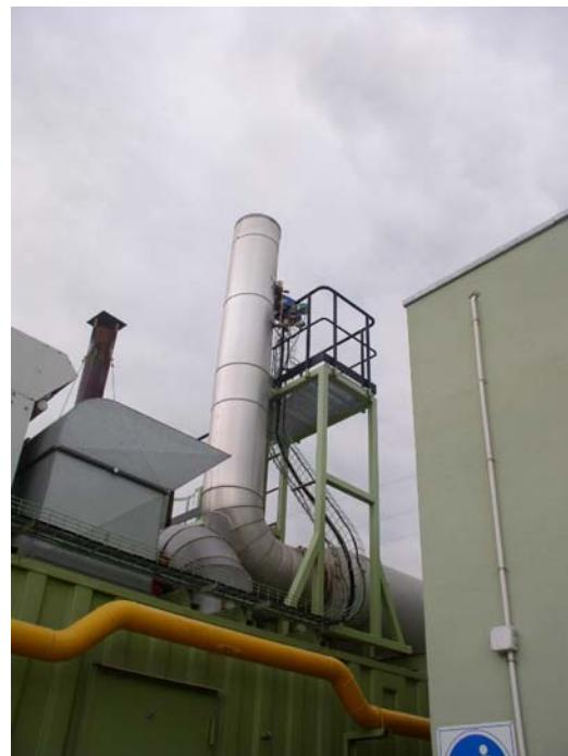
A fin de poder corregir los valores de emisión de los componentes medidos en condiciones estándar, se toma también medición de caudal, temperatura y presión de los gases de escape.
