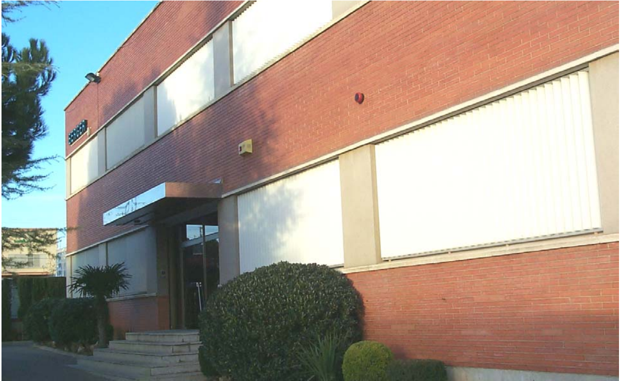
Vista exterior de la planta – Vista exterior de la planta
