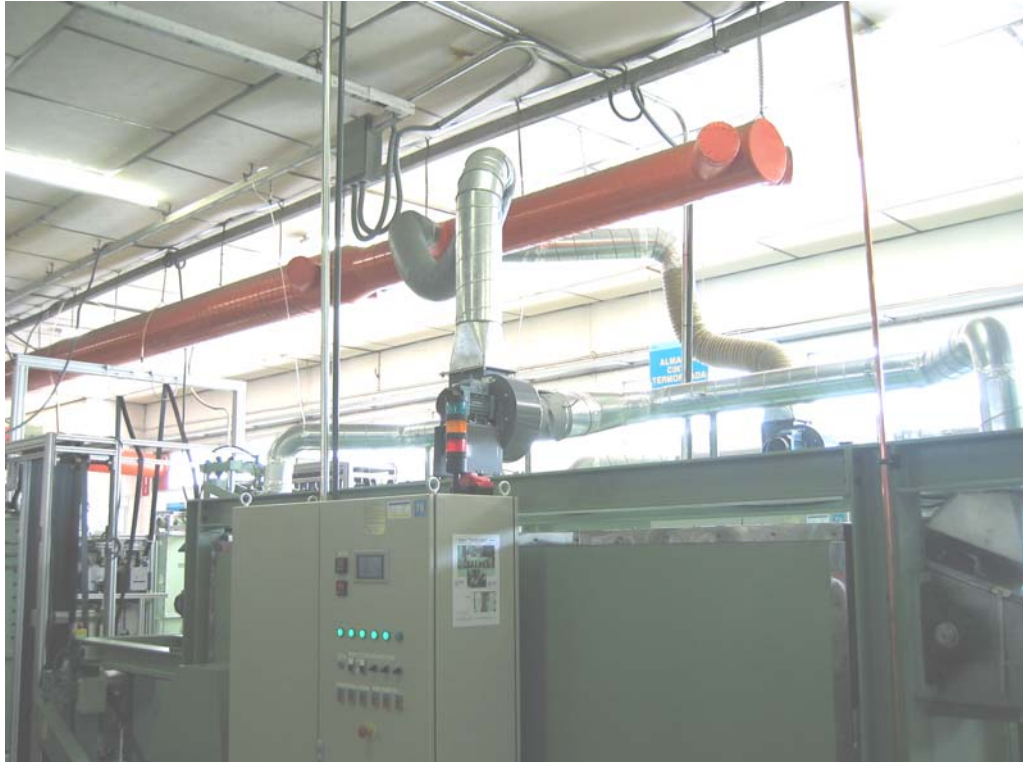
Horno de termofijar, campana de extraccion de humos –Forn de termofixar, campana d'extracció de fums
