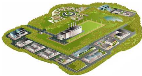
Planta de separación selectiva
