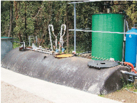
Imagen - Compacto biológico tricompartmentado, nitrificante-desnitrificante para aguas residuales sanitarias
