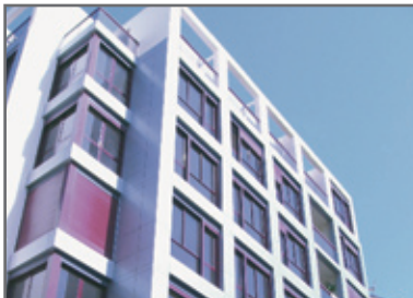
Terminación obra Eurocan, Las Palmas.
