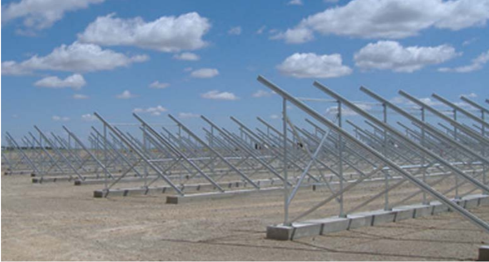
Parque fotovoltaico en construcción. Herencia, Ciudad Real.
