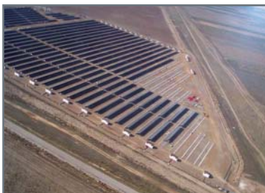
Finalización del parque fotovoltaico de Abenójar.
