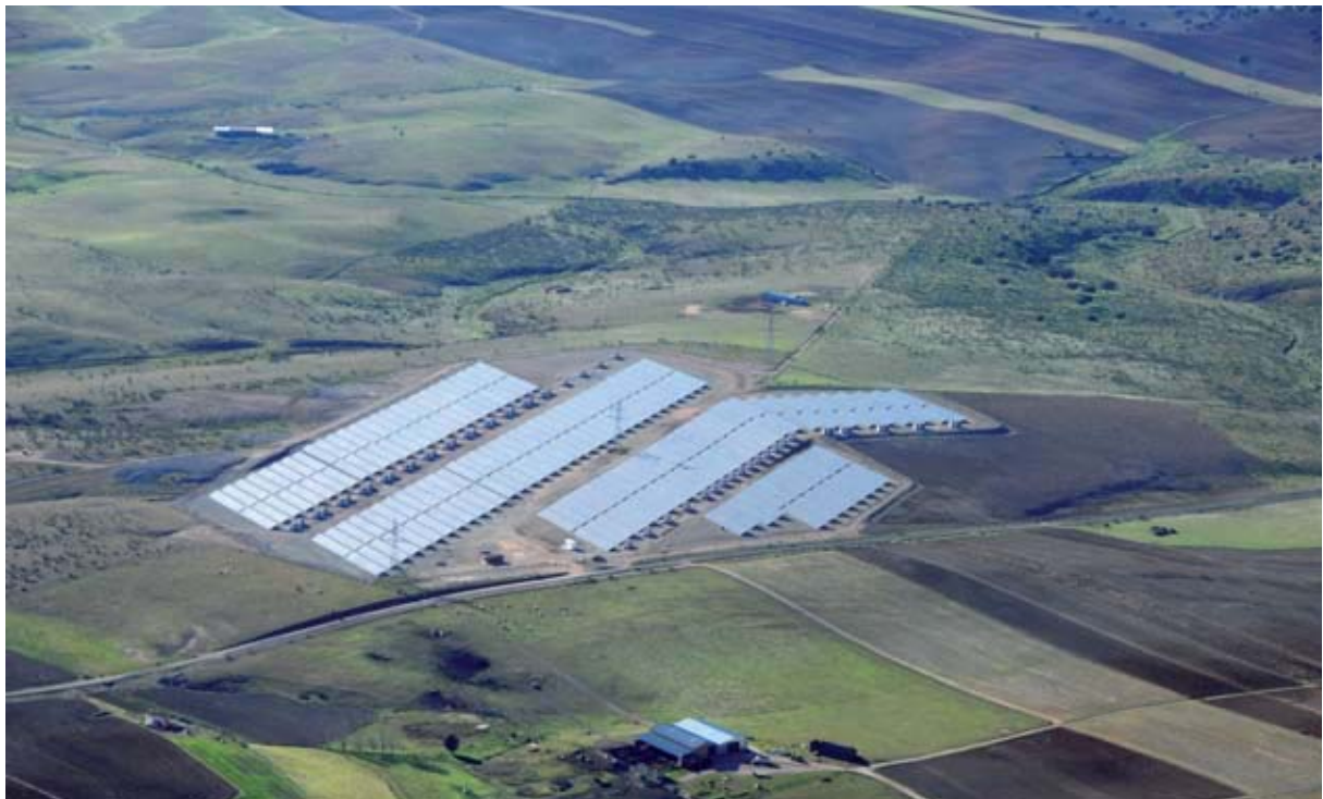
Parque fotovoltaico de Abenójar, Ciudad Real.
