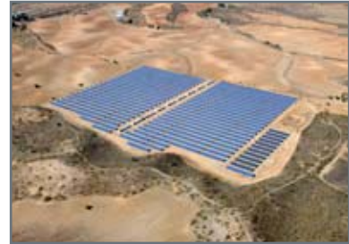
Finaliza la construcción del parque de Bargas.
