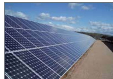
Finaliza la construcción del Parque de La Carolina.
