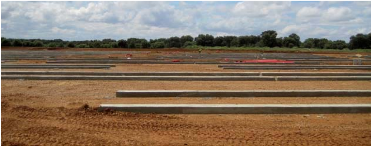
Comienzo de las obras del Parque fotovoltaico de Villabrázaro, Zamora.
