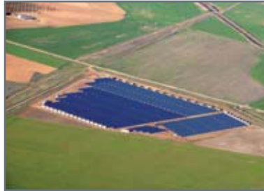
Finaliza la construcción del parque de Herencia.
