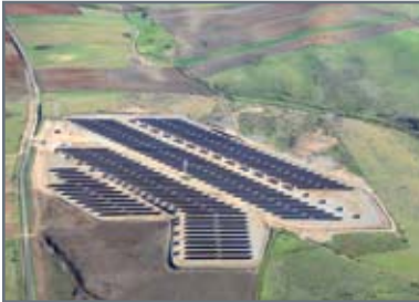
Finaliza la construcción del parque de Abenójar.
