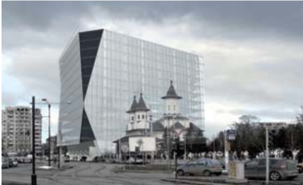
Edificio de oficinas Serban Voda, Bucarest.
