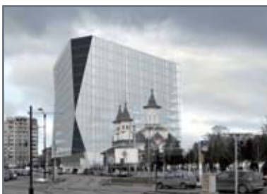
Edificio de Oficinas Serban Voda (Bucarest).
