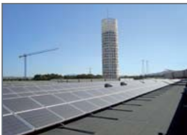
Instalación de cubierta fotovoltaica de Hervaz.
