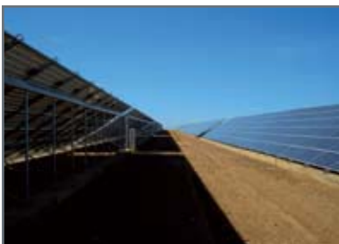
Finaliza la construcción del parque de Villabrázaro.
