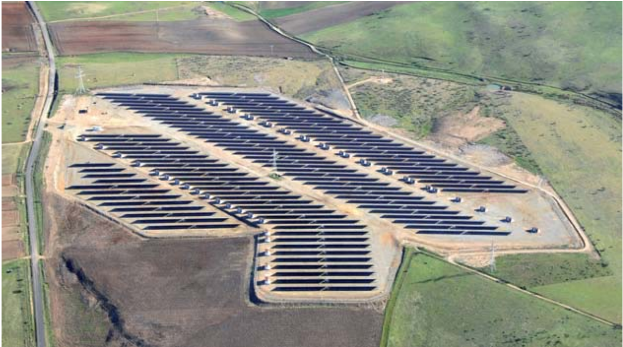
Parque fotovoltaico de Abenójar, Ciudad Real.
