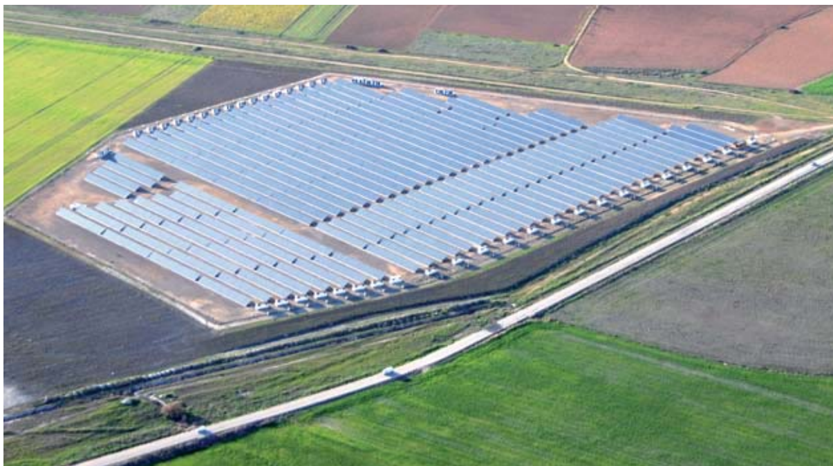
Parque fotovoltaico de Herencia, Ciudad Real.
