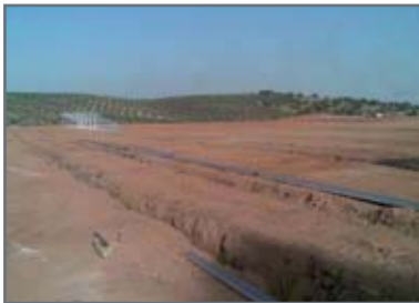
Comienzan las obras del parque de La Carolina.
