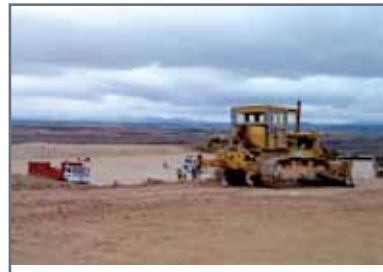
Comienzo de la construcción del parque de Heras de Ayuso
