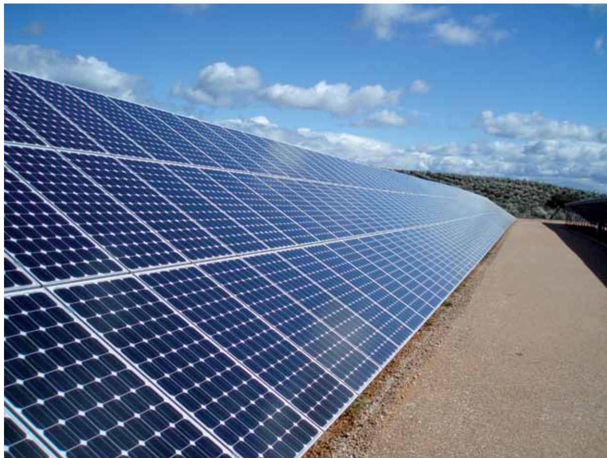
Parque fotovoltaico de La Carolina
