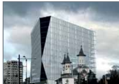
Último avance para el proyecto Servan Boda
