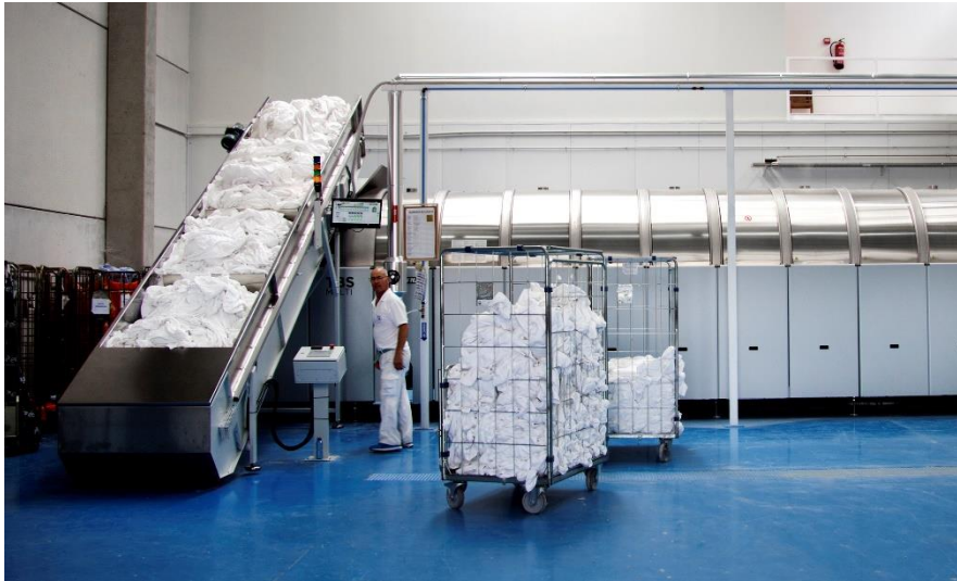
Sistema túnel de rentat
