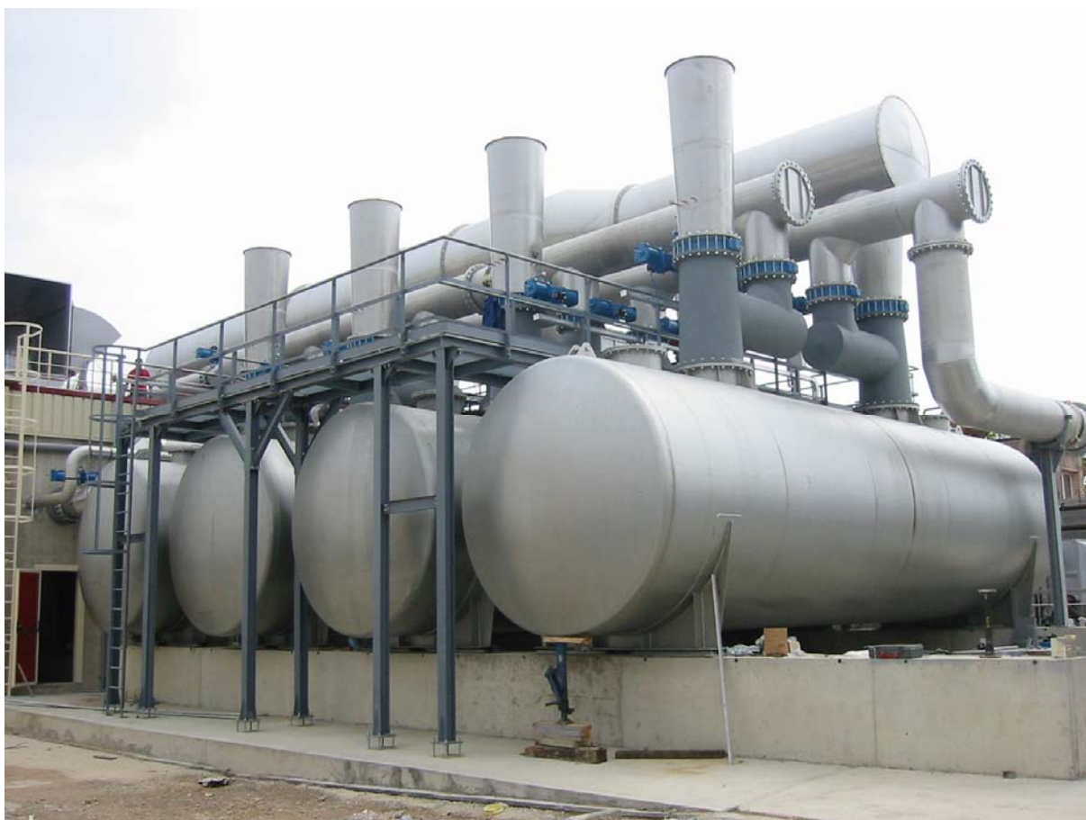
Planta de recuperación de disolventes. Depósitos de adsorción
