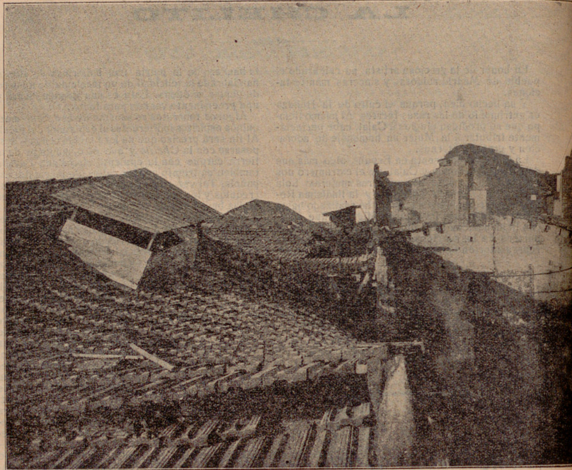
Lo que ha quedado de la fábrica de los señores y Fradera, incendiada el día 8 del actual.
