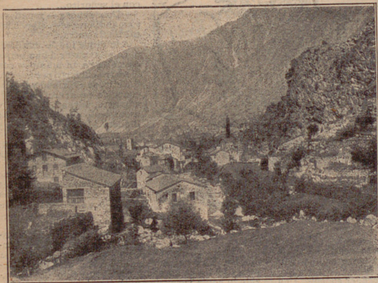
LES ESCALDES.—El puente dels Escorcons.
