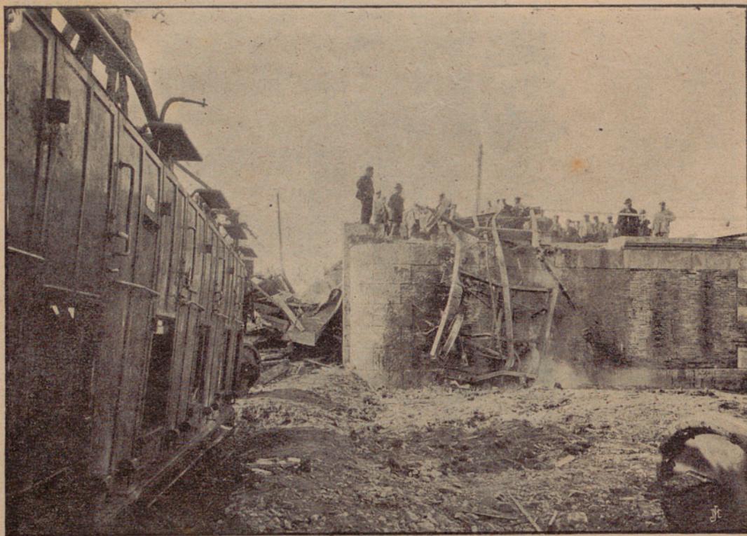
La parte del puente hundida al paso del tren. A la izquierda ap. rese volcado uno de los vagones
