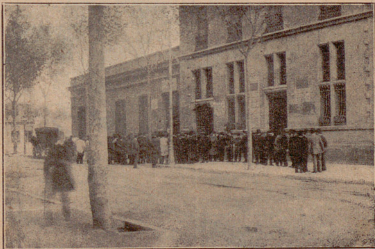
Frente á uno de los colegios de la calle del Bruch
