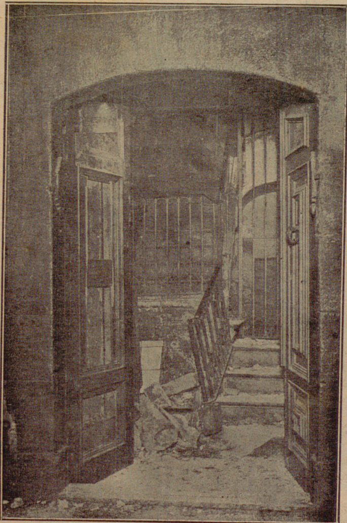
Destrozos causados por la bomba que hizo explosión en la casa núm. 2 de la calle de San Ramón, en la tarde del día 17.
