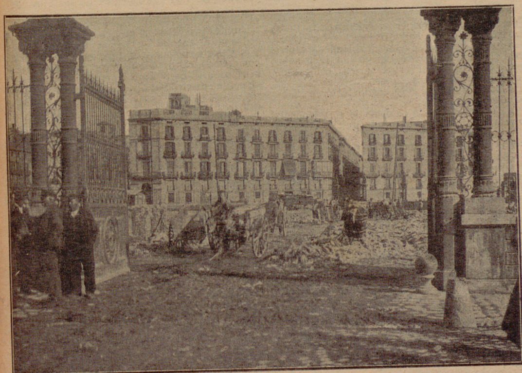
Sitio donde estaba instalado el tinglado número 9 del Puerto, que ha sido destruido por un incendio.
