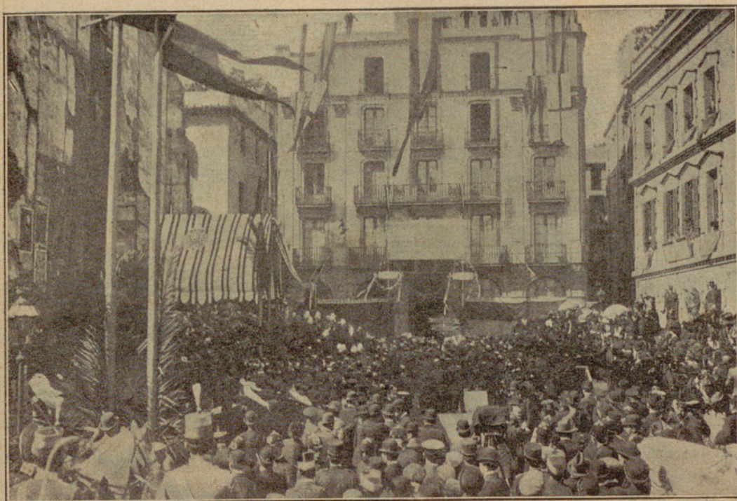
Aspecto de la calle de la Reina Regente en el momento en que Alfonso XIII quitaba una piedra de la casa número 71 de la calle Ancha, por la que ha comenzado el derribo.
