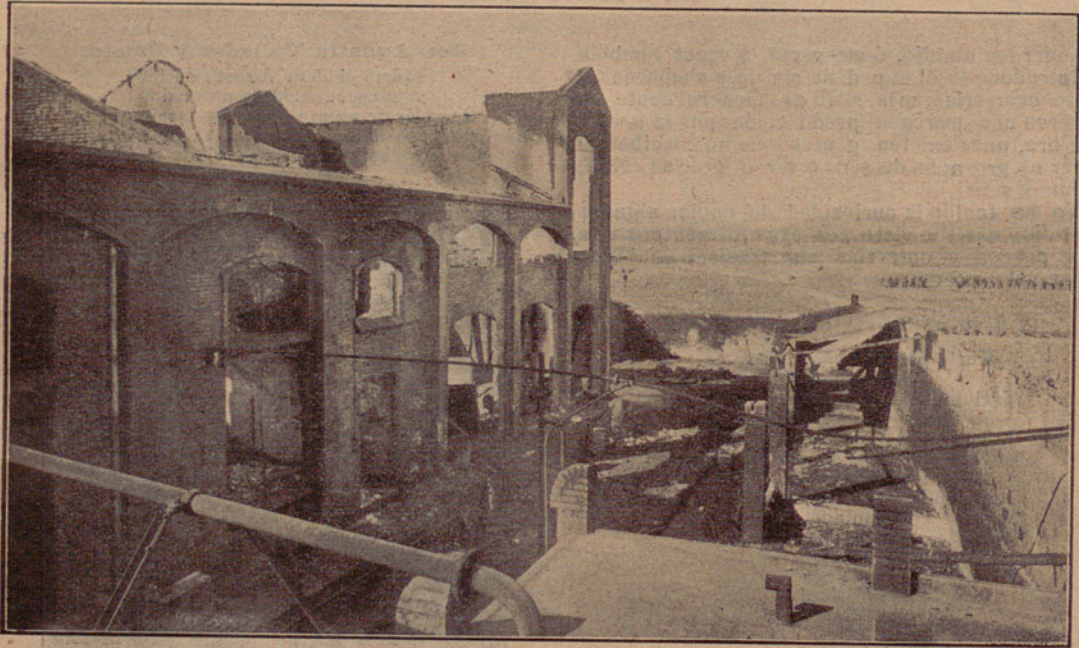
Estado en que, á consecuencia del incendio que en ella se declaró, ha quedado la fábrica de alquitrán que los señores Tey tenían establecida en Badalona.
