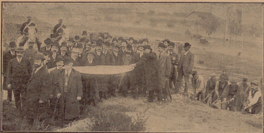
Acto oficial de la apertura de la calle de Lérida, situada en la barriada del Pueblo Seco.
