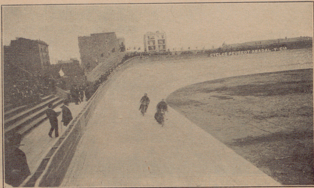
Vista parcial de la pista del nuevo velódromo barcelonés «Parque de Sports».
