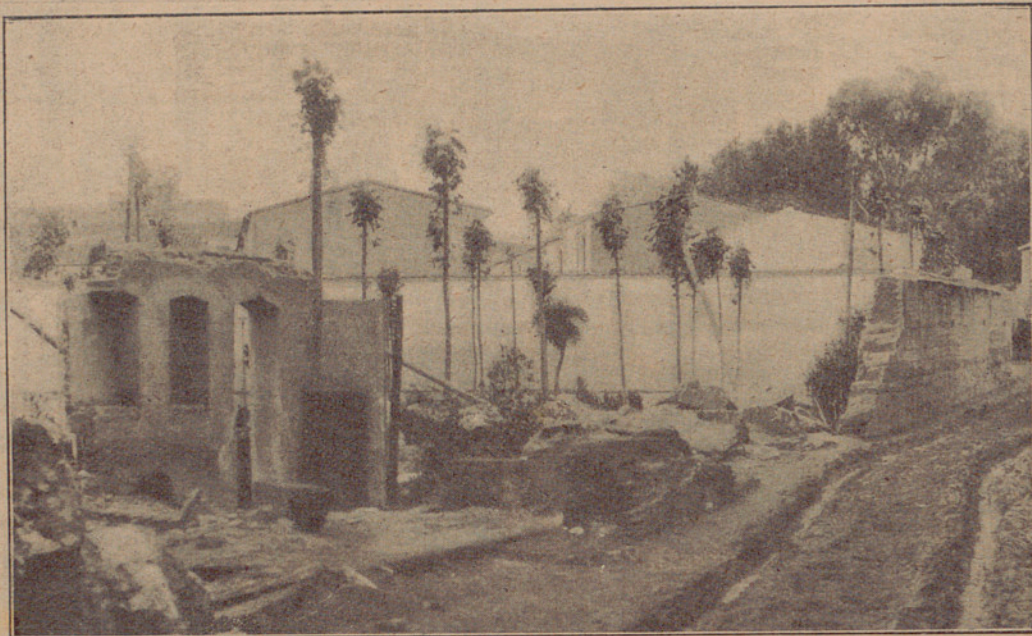
Inundación en Masnou.—Pared del jardín del Casino, en parte arrastrada por las aguas, que anegaron todo el edificio.
