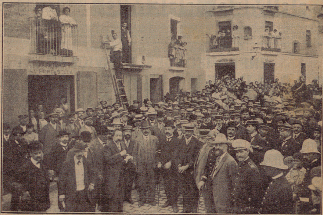
Momento en que se dió principio á las obras de derribo de las casas que han de desaparecer de la calle del Hostal, para que pueda realizarse su prolongación.
