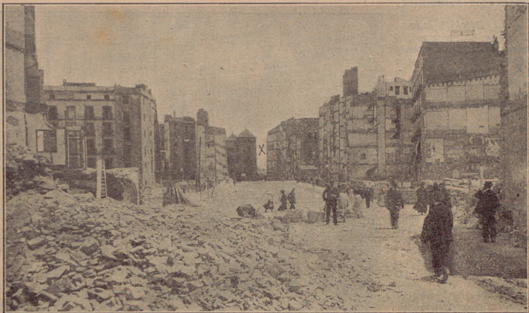
Trozo de la primera sección de la Granvia A, comprendido entre la que fué plazuela de Basea y la calle del Consulado. En último término X vese el mar.
