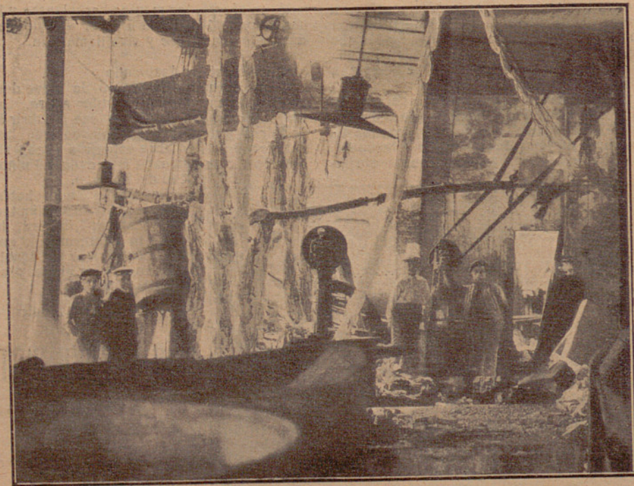
Efectos de una explosión. — Estado en que quedó uno de los departamentos de la fábrica de blanqueo que los señores Illa tienen establecida en San Martín de Provencals.
