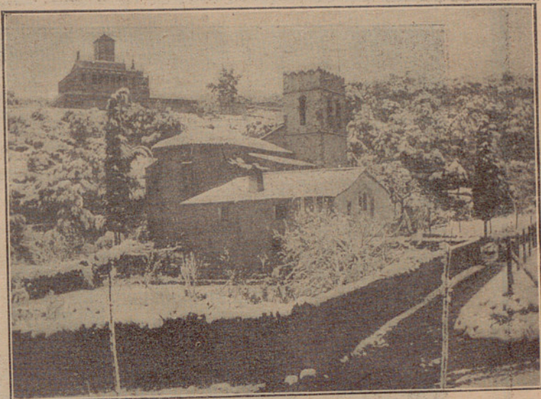
VALLVIDRERA. — Aspecto que ofrecían después de la nevada la iglesia parroquial y Villa Juana.
