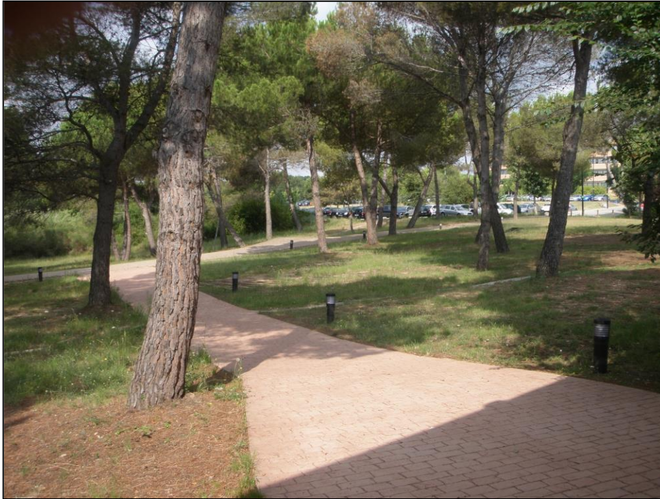
Pista mixta que enllaça el pàrquing del rectorat amb la Plaça Cívica i l'Estació de FGC del campus UAB.
