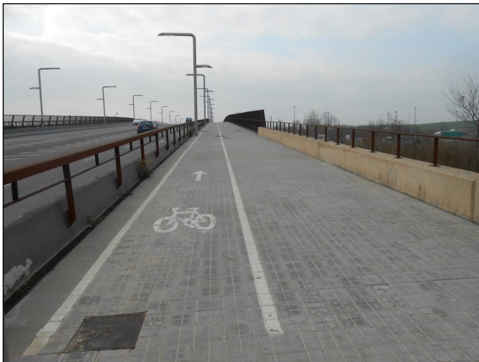
Vorera bici al pont sobre l'autopista AP7, part sud del campus.
