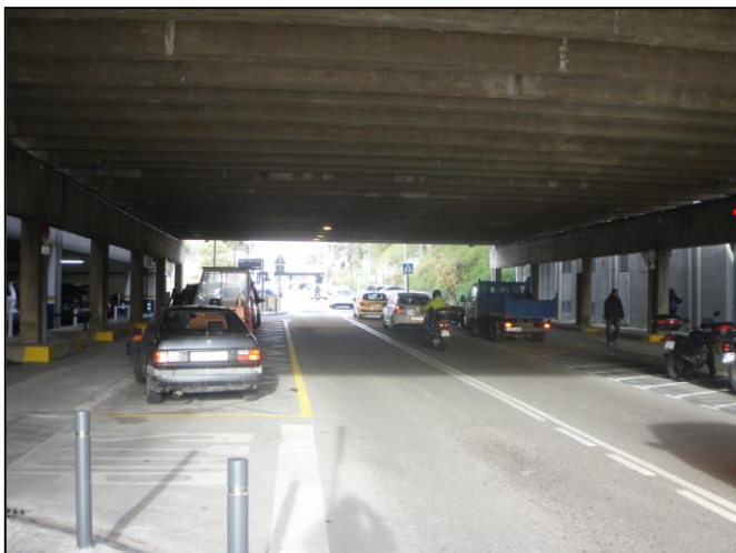
Pont de l'edifici B (EC2)
