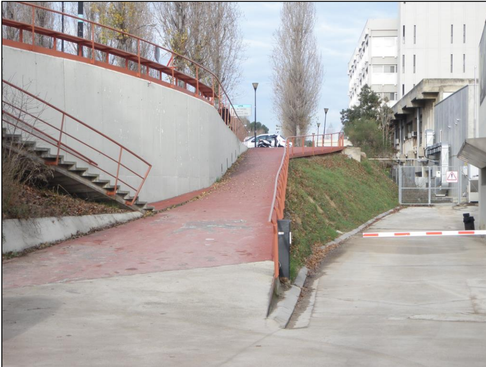
Rampa existent ubicada darrera del SAF.
