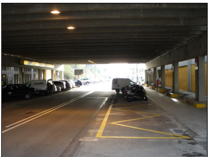
Pont de l'edifici C (EC2)
