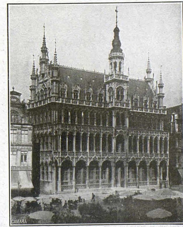
Fachada principal de la casa del Rey
