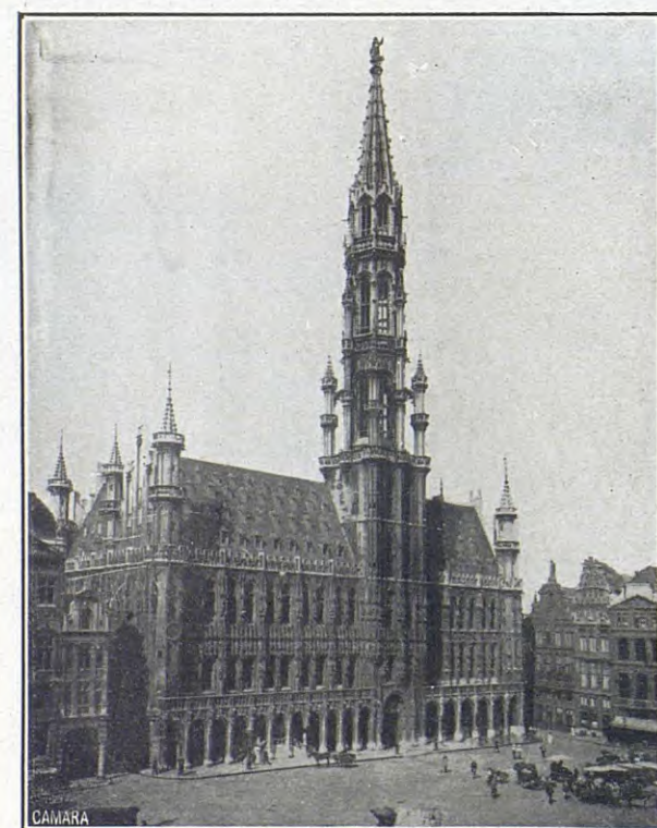
Fachada principal de la casa Ayuntamiento
