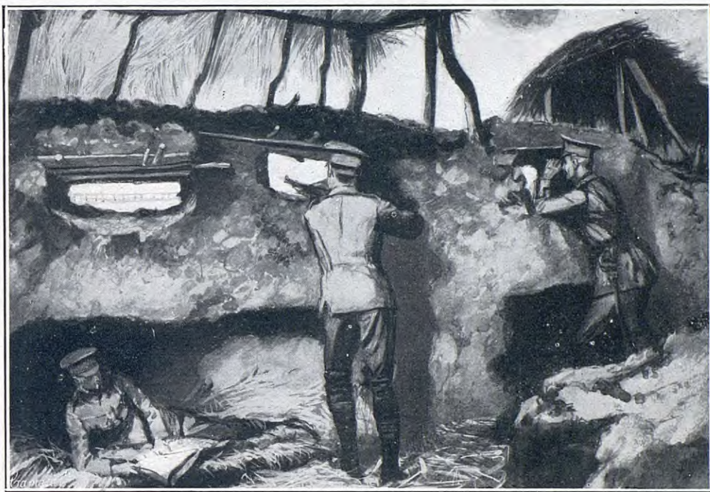
Interior de una trinchera construida por los ingleses en el Marne
