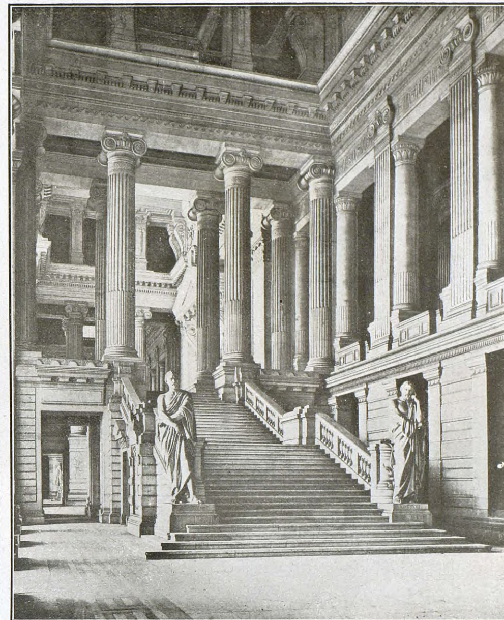
Detalle de la escalera principal
