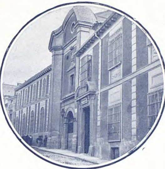
Hospital de la V. O. T. en las antiguas casas de Gil Imón de la Mota, de la calle de San Bernabé, de Madrid
