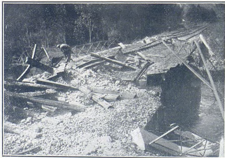
La vía férrea de Amiens (Francia), destruida por efecto de la guerra FOT. ROL
