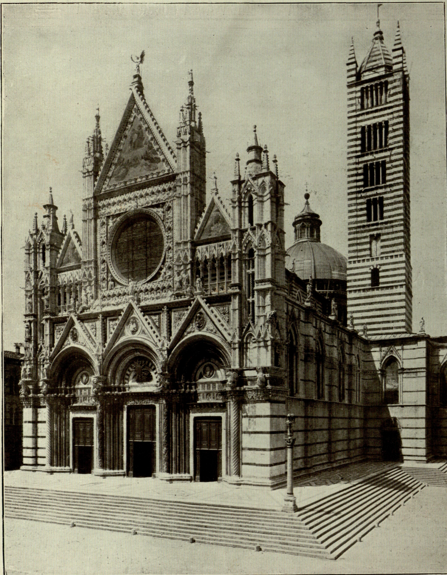
FACHADA PRINCIPAL DE LA CATEDRAL DE SIENA
