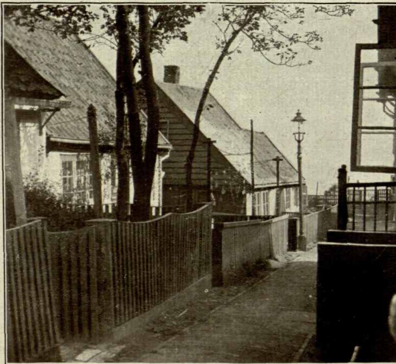
Vista de una calle de Heligoland
