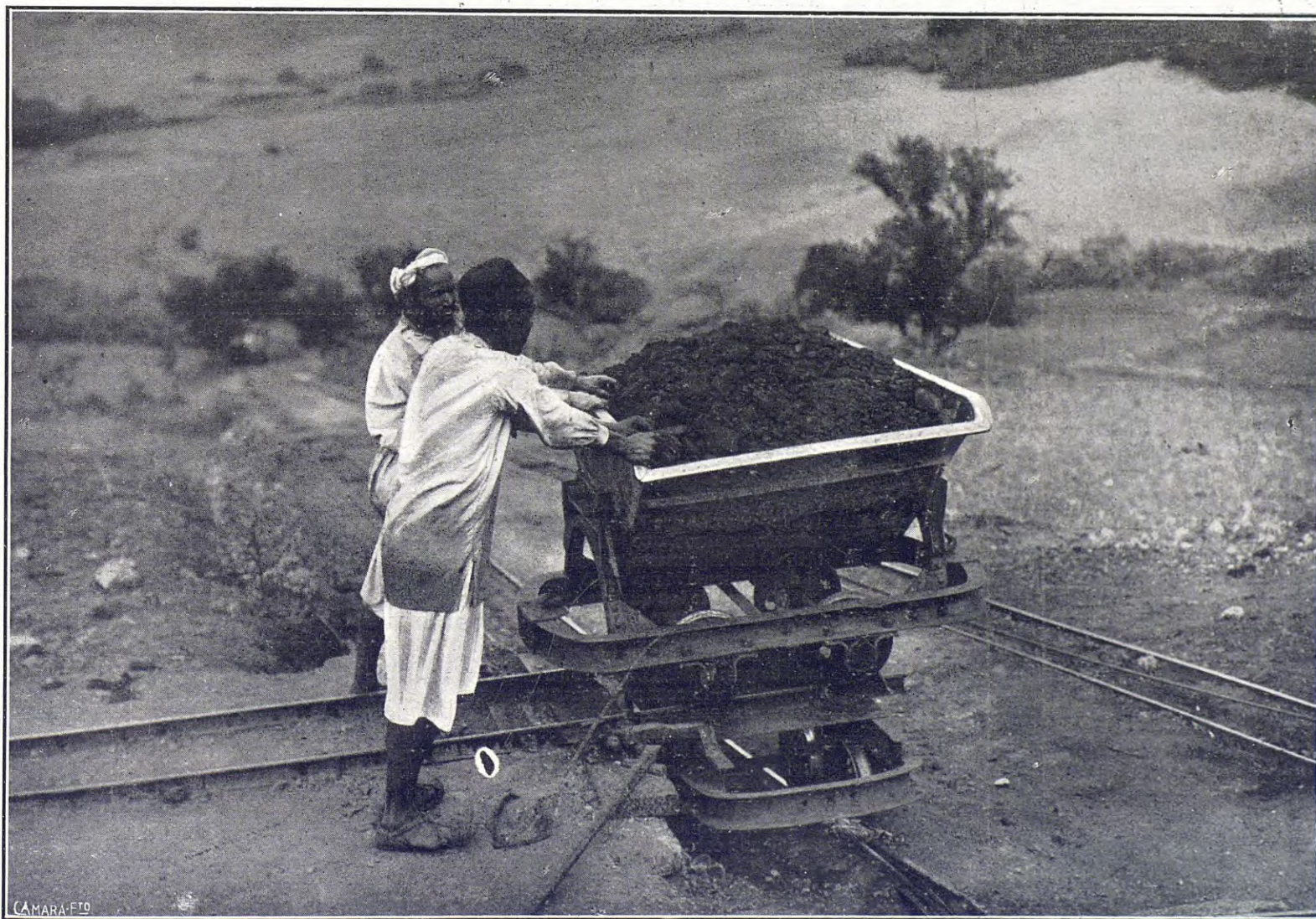
Moros colocando las vagonetas en el plano inclinado para trasladarlas a los cargaderos de las minas de "La Alicantina" FOTS. LÁZARO
