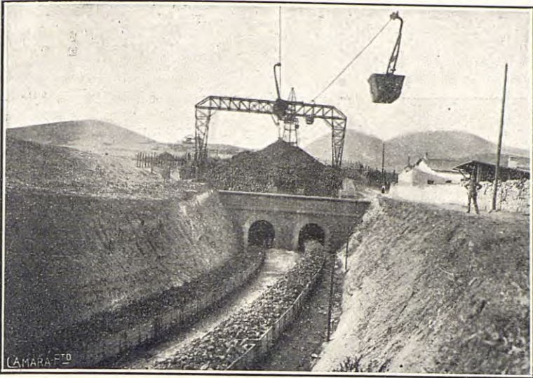
Depósito regulador de 40.000 toneladas de capacidad, situado en el término del tranvía aéreo para la carga de trenes
