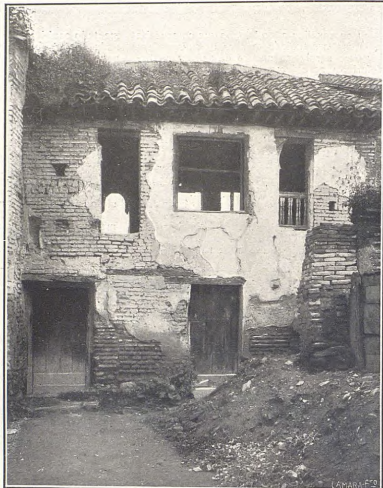
Casita árabe contigua á la que se ha hundido, que está en peligro de desaparecer por el abandono en que se la tiene
