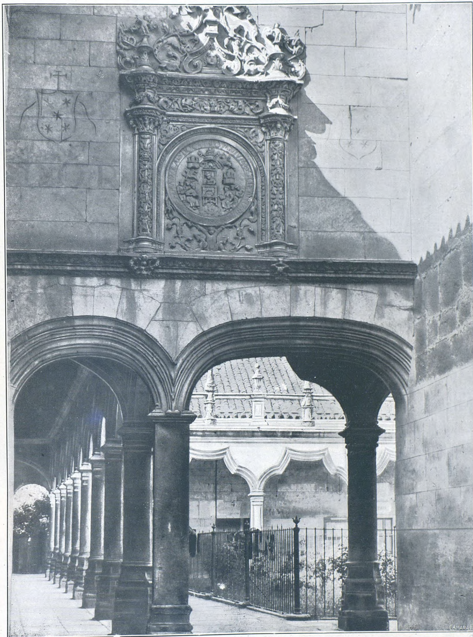
SALAMANCA.—ENTRADA AL PATIO DE ESCUELAS MENORES, EN DONDE HOY ESTÁ INSTALADO EL INSTITUTO, Y QUE EN LA EPOCA DE SU FUNDACION LLAMOSE "HOSPITAL DEL ESTUDIO" FOT. KURT HILSCHER
