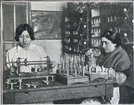
Preparación y montaje del filamento sobre el soporte de cristal
