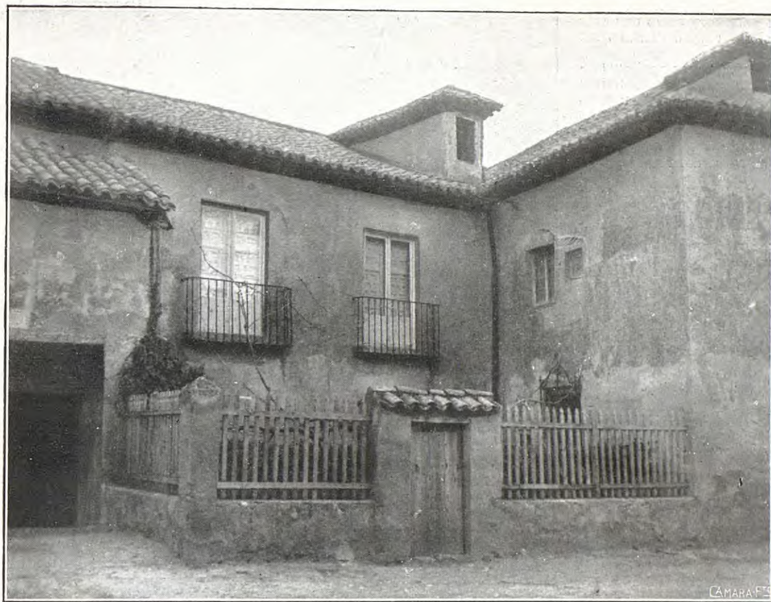
Fachada posterior de la casa de la esposa de Cervantes, en Esquivias
