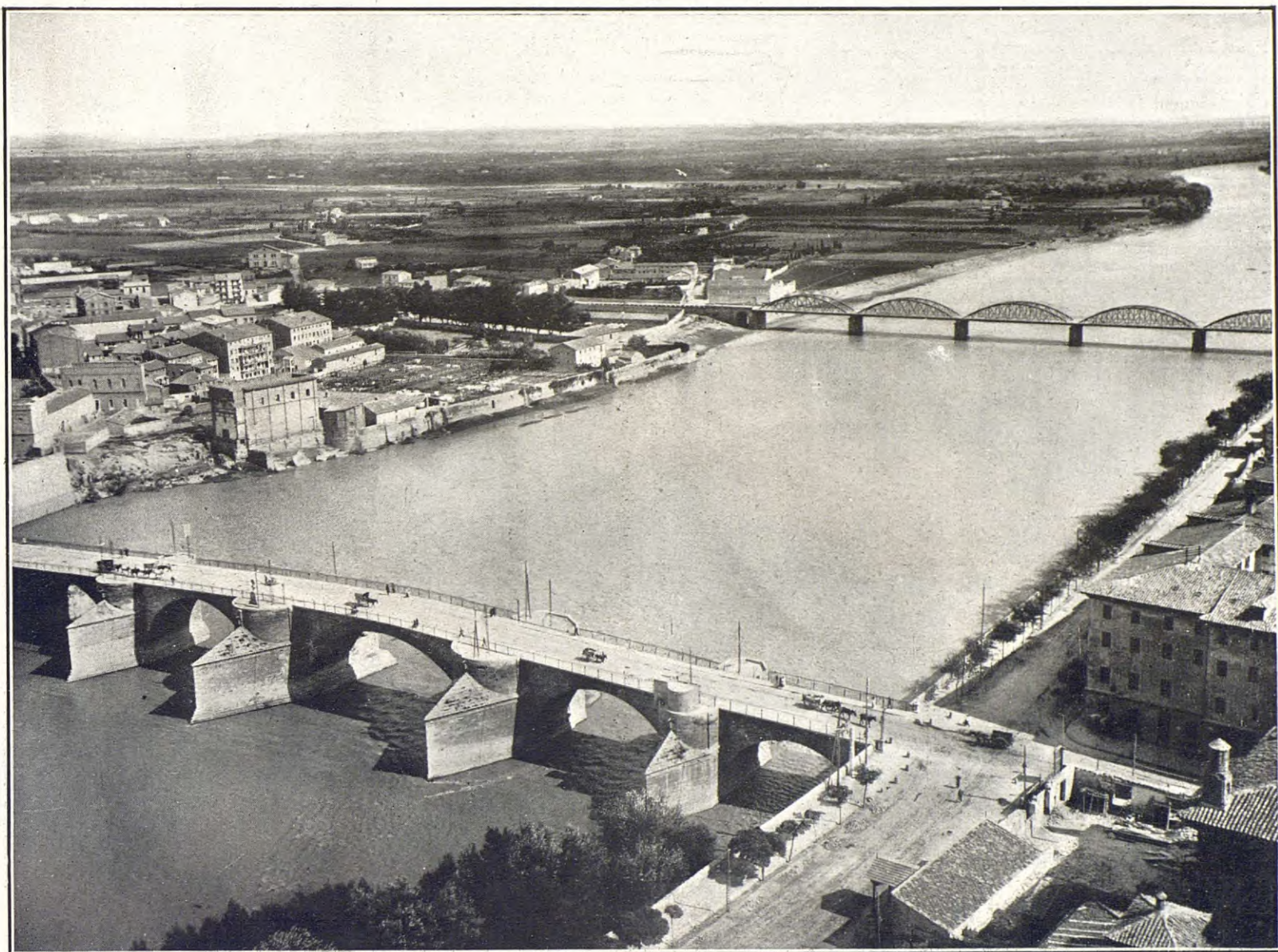
El puente de piedra y el puente del Pilar, sobre el Ebro
