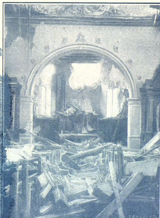
Otro de los templos que, al retirarse los alemanes, dejaron destruidos
