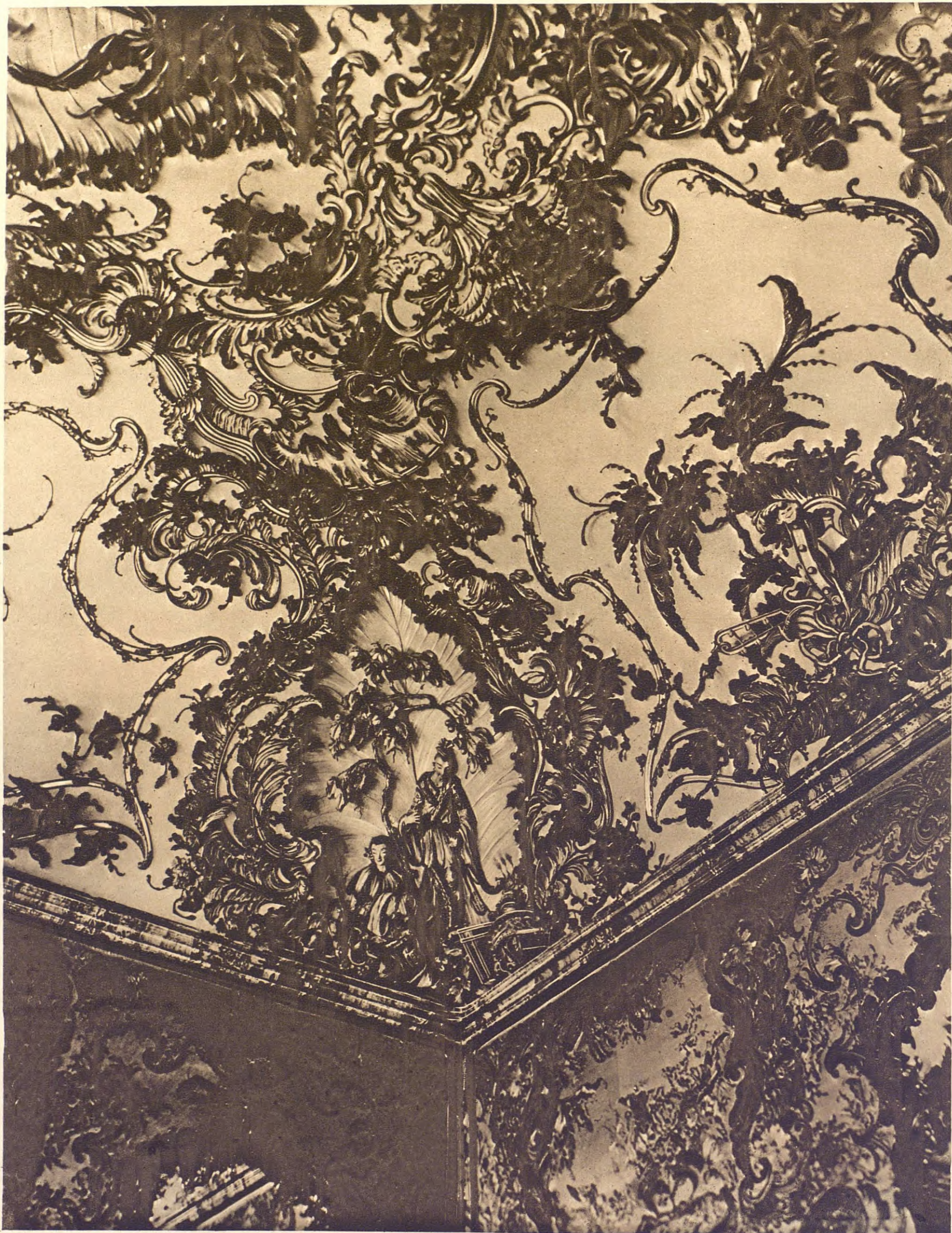
DETALLE DEL TECHO DEL SALÓN GASPARINI
