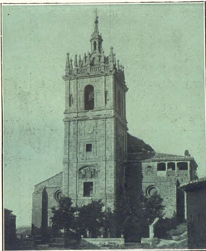
Fachada principal y torre
