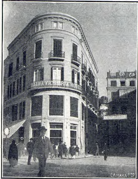
Fachada del Reina Victoria Hotel, de Málaga
