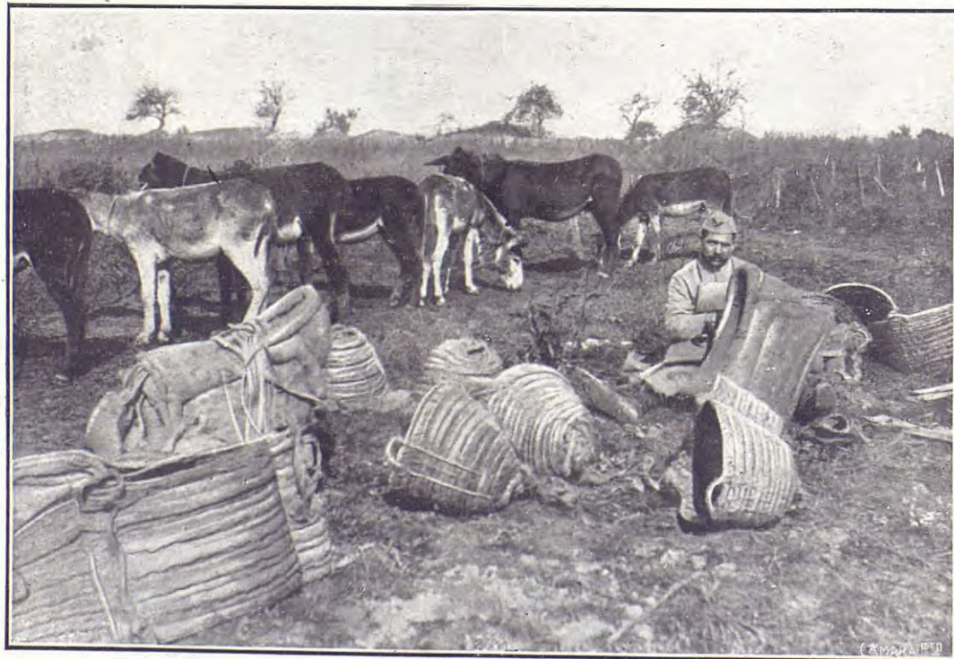
Asnos de las trincheras pastando mientras se reparan las bardas
