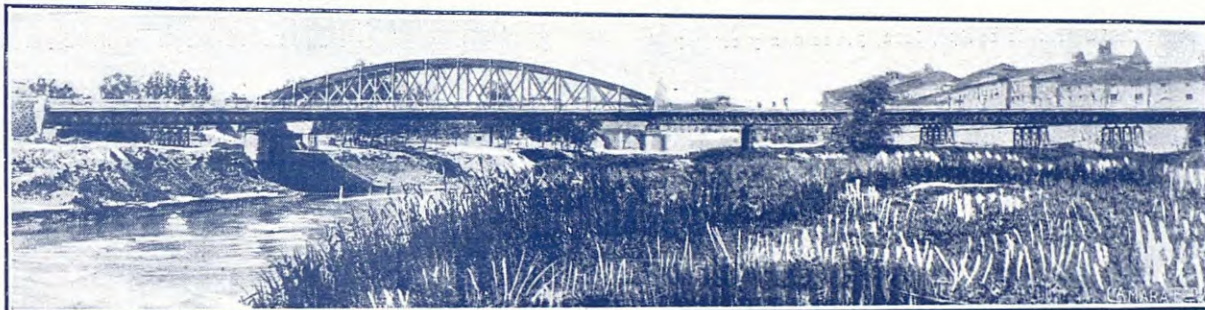
Puente de 140 metros de longitud total y 47 metros en el tramo parabólico, apoyado en pilas tubulares, construido por la Sociedad sobre el río Segura
