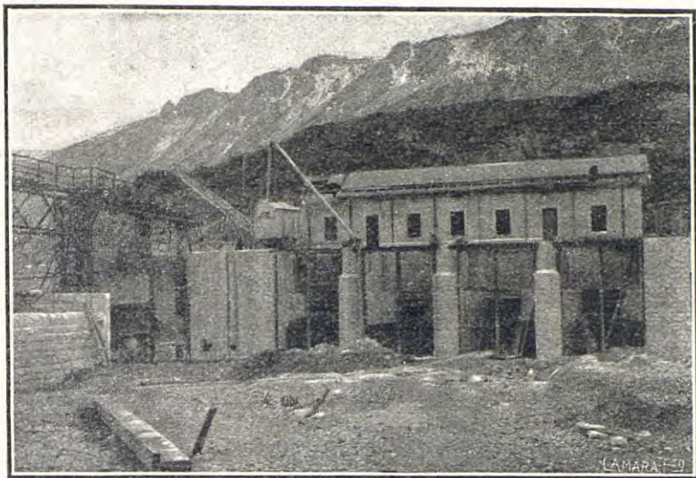
Salto del Run (Huesca). Tomas de agua y compuertas de la presa
