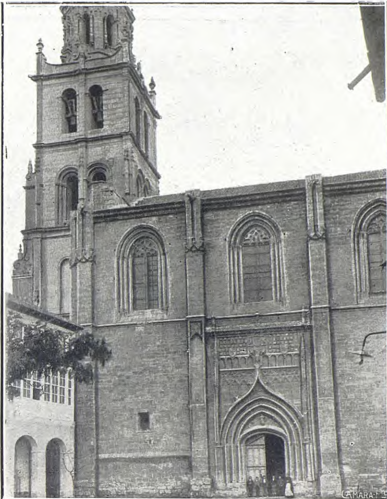
Vista exterior de la iglesia
