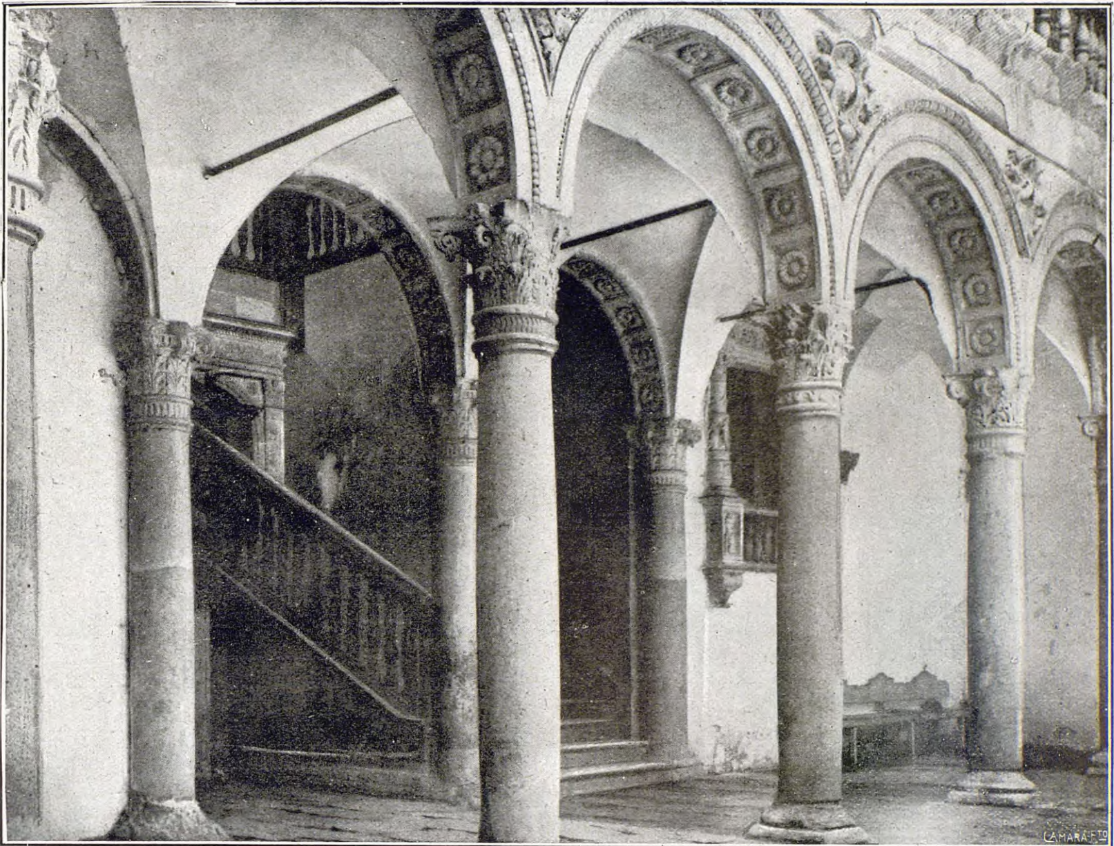
Escalera y detalles del patio
