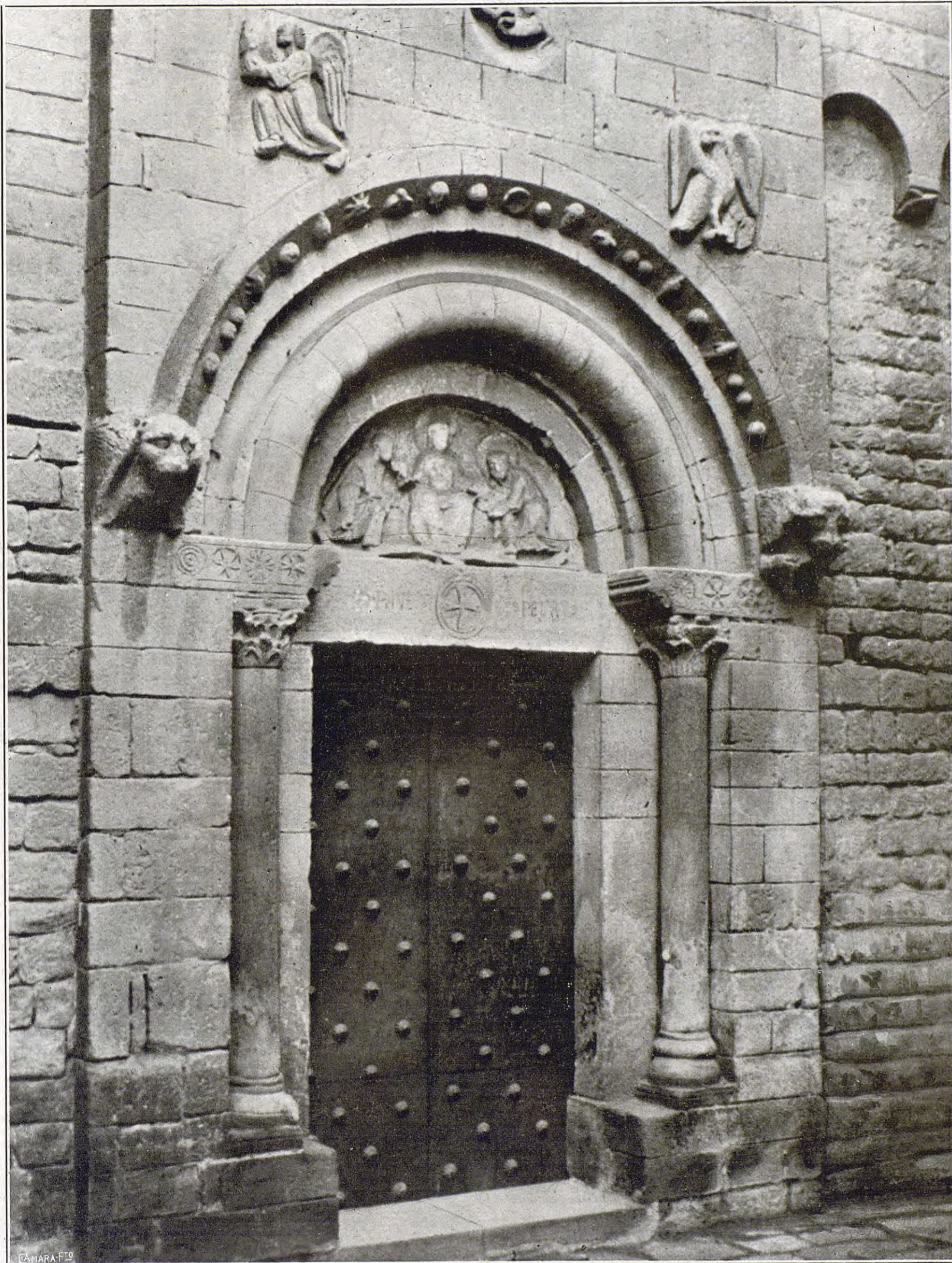
PUERTA PRINCIPAL DE LA IGLESIA PARROQUIAL DE SAN PABLO DEL CAMPO, DE BARCELONA, PERTENECIENTE AL MÁS PURO ESTILO ROMÁNICO, Y CUYA CONSTRUCCIÓN SE REMONTA AL SIGLO XII
