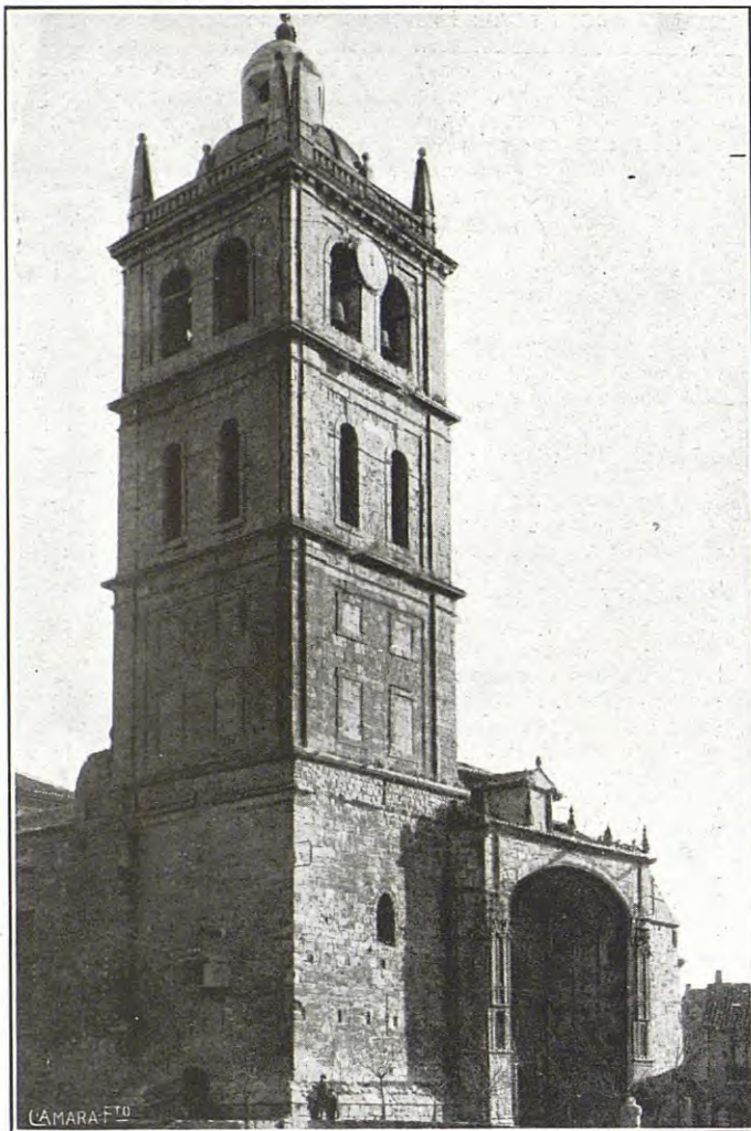
Torre y pórtico de ingreso á la iglesia parroquial de Dueñas
