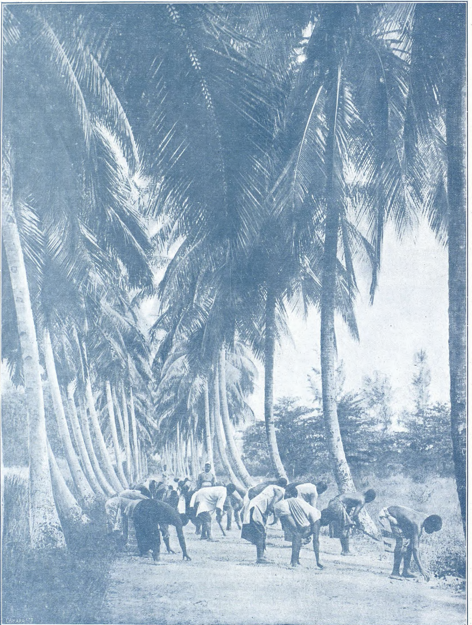
Prisioneros de Duala ocupados en la reparación de una carretera
