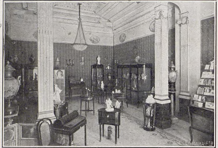
Interior del despacho de la calle de la Paz
