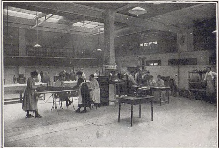
Vista general de la sala de elaboración
