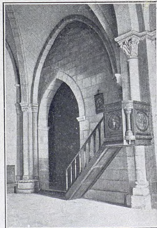
Interior de la iglesia
