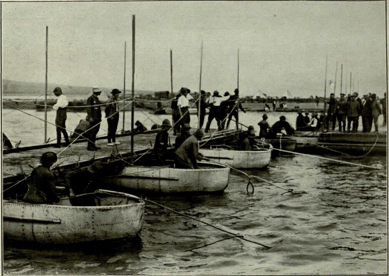
Ingenieros militares tendiendo un puente sobre barcazas, en la bocana de Mar Chica, para facilitar el paso de los convoyes á la Restinga FOT. CAMPÚA
