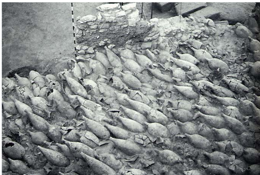
Figura 4.- Campo de Ánforas hallado en la Plaza de las Tenerías (Zaragoza) para el drenaje.
