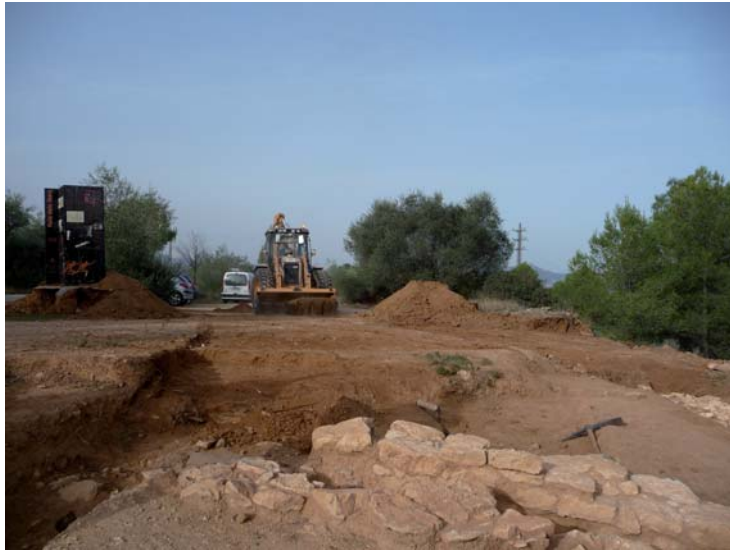
Fotografia 1: treballs d'excavació de la UE 1 amb màquina retroexcavadora a la zona 3
