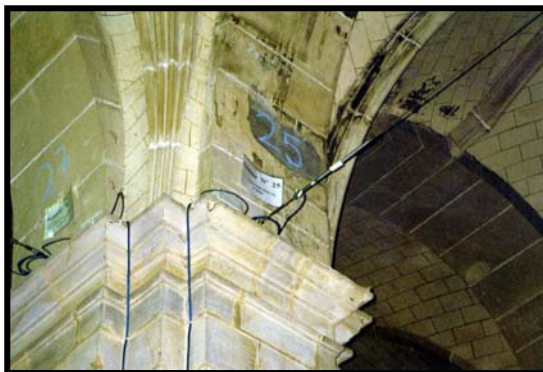
Cintas de convergencia de 50 mm.
